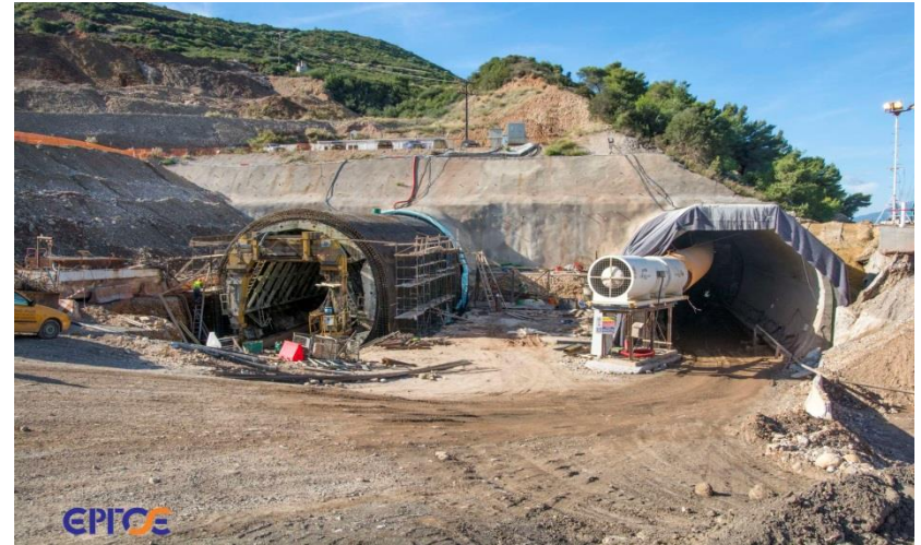
Cut and Cover εισόδου σήραγγας Παναγοπούλας
