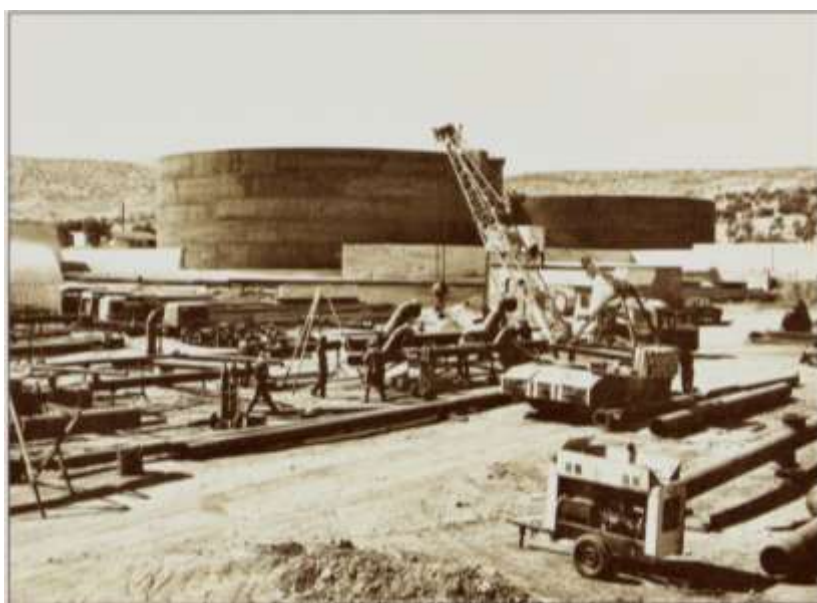
Κατασκευή δεξαμενής στο διωλιστήριο της Πετρόλα Ελλάς (1971)
