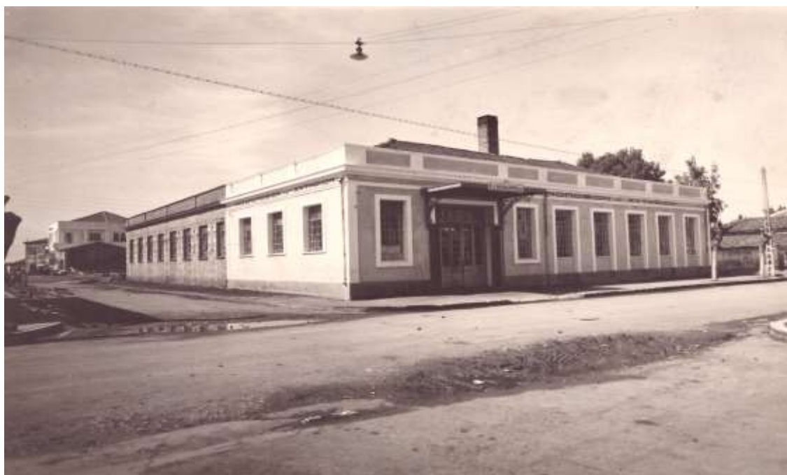
Άποψη εργοστασίου Θεοχάρη, 1935
